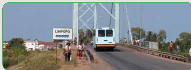
Ponte do Limpopo
